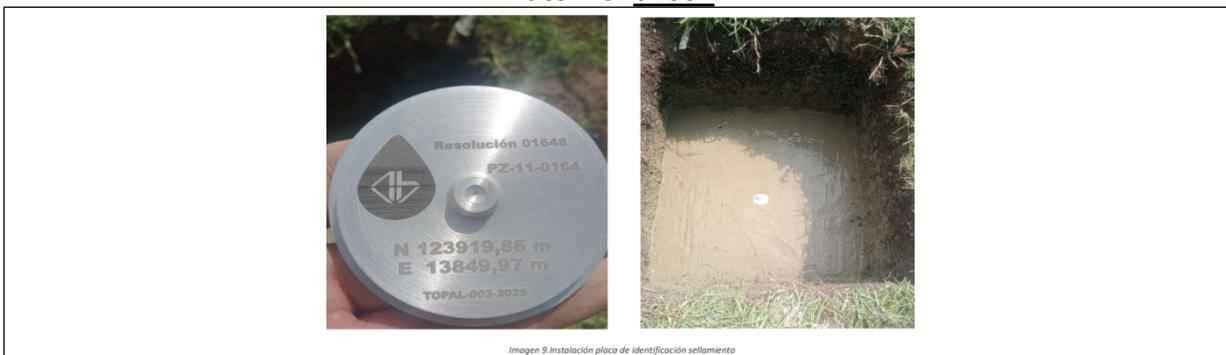
Imagen 9. Instalación placa de identificación sellamiento
